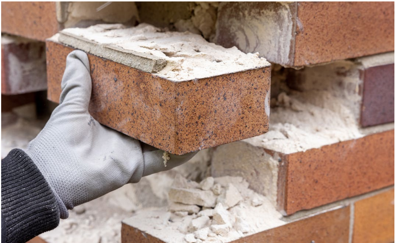
Handarbeit: Um die Ziegelsteine wiederzuverwenden, werden sie vorsichtig aus der Fassade gelöst. (© Foto: Wienerberger)
