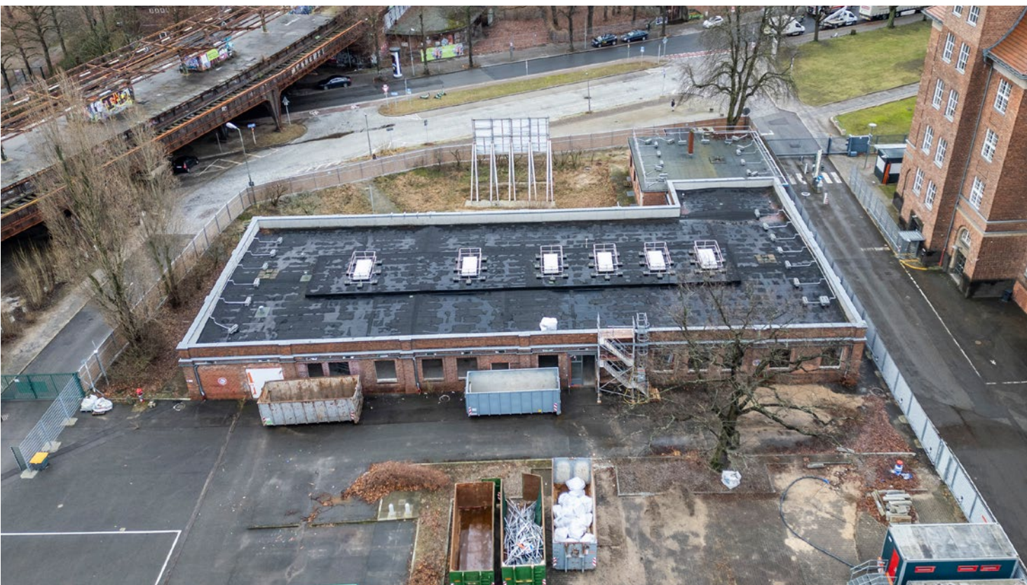
Blick auf das Pförtnerhaus vor dem Abriss
